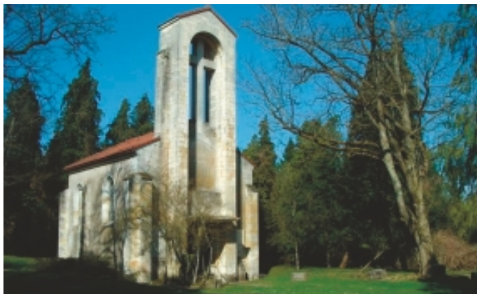
Village détruit de Remenauville
