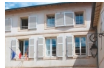
Logements à Thiaucourt
