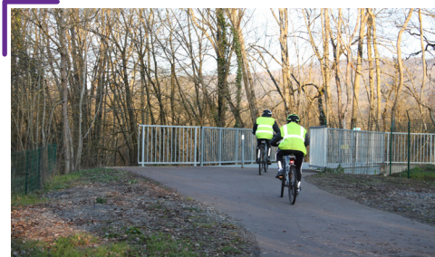
Pont éclusier d'Arnaville
