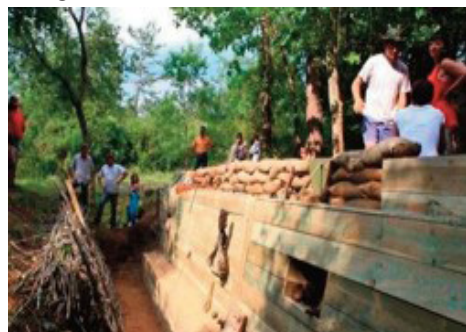
Tranchées de Saint-Baussant
