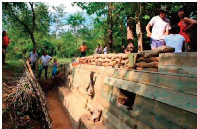
Tranchées de Saint Baussant
